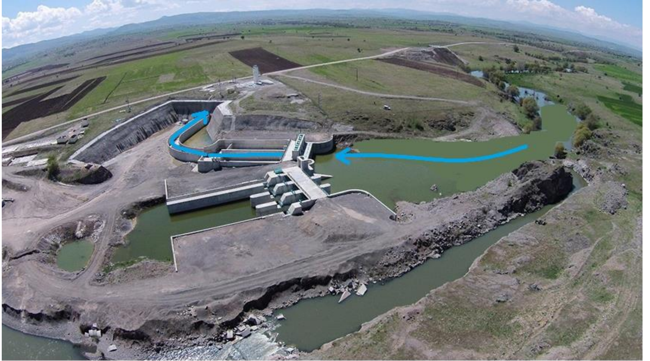
Gerede tüneline suyu çeviren çevirme yapısı (Işıklı Regülatörü)
