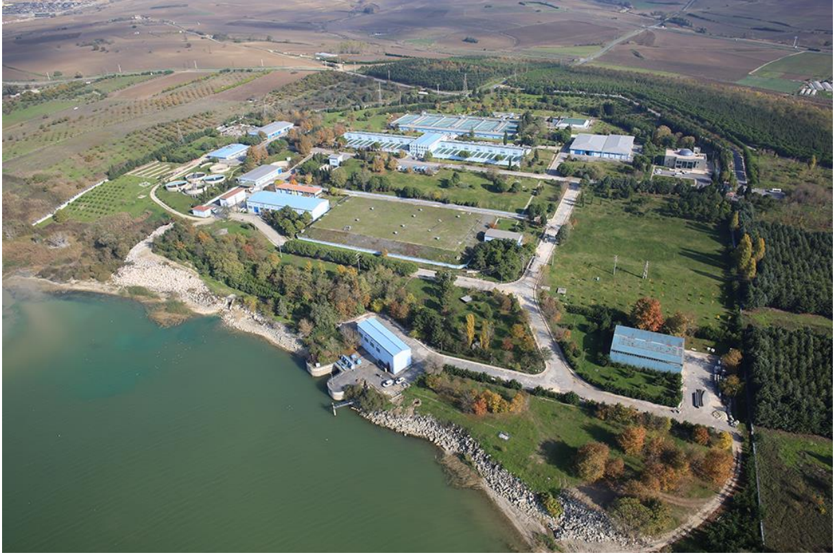
Şekil 7. Büyükçekmece İçme Suyu Arıtma Tesisi.
