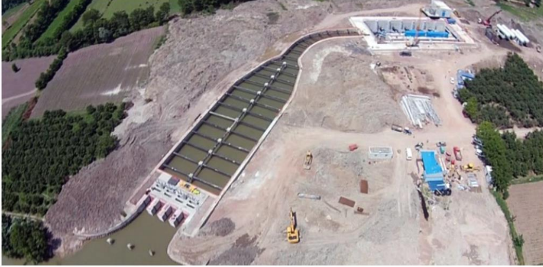
Şekil 16 Sakarya Nehri Su Alma Ağız ve Pompa İstasyonu inşaatı
