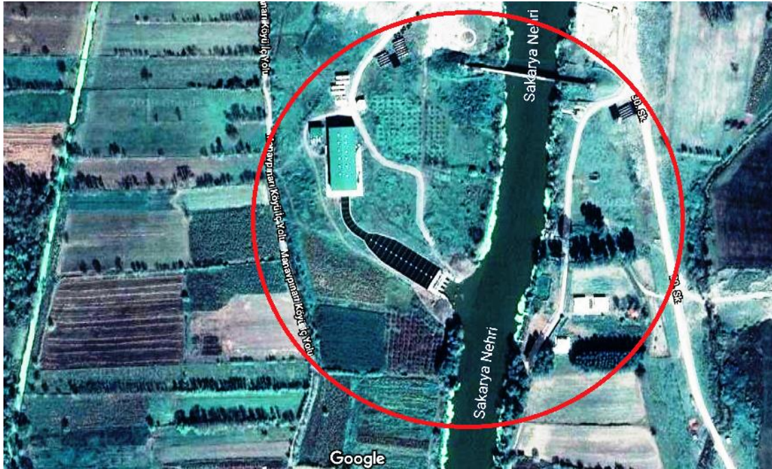
Şekil 15. Sakarya Nehrinden İstanbul'a ilave su temin edilen su alma ağız girişi ve pompa istasyonu
