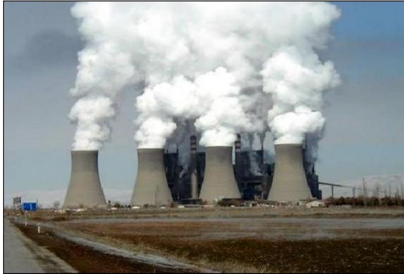
Şekil 15 a. Denizsuyu Kullanan Mekanik Akımlı Islak Tip Soğutma Sistemi (İzdemir Termik Santrali).
