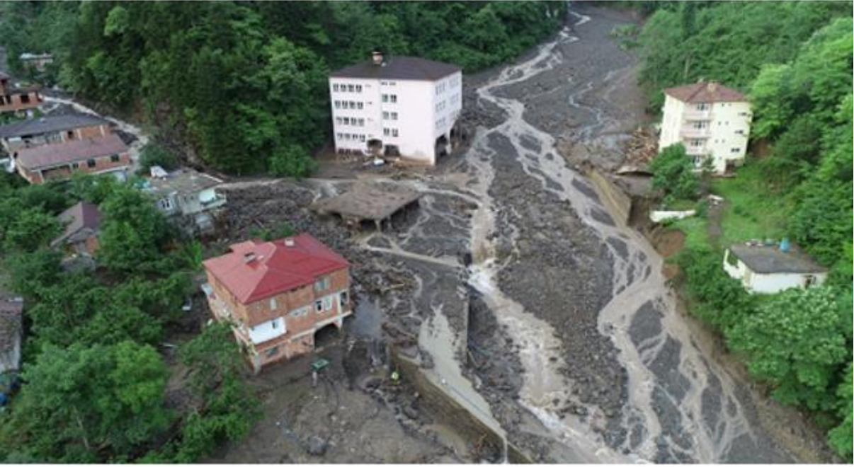
Foto 7. Araklı taşkını süresince ve taşkıdan sonra nehir yatağının durumu
