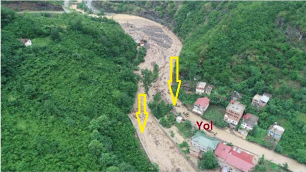
Foto 8.Nehir yatağında yapılaşma nedeniyle daralan nehir enkesiti ve taşkınin nehir yatağından karayoluna yayılması
