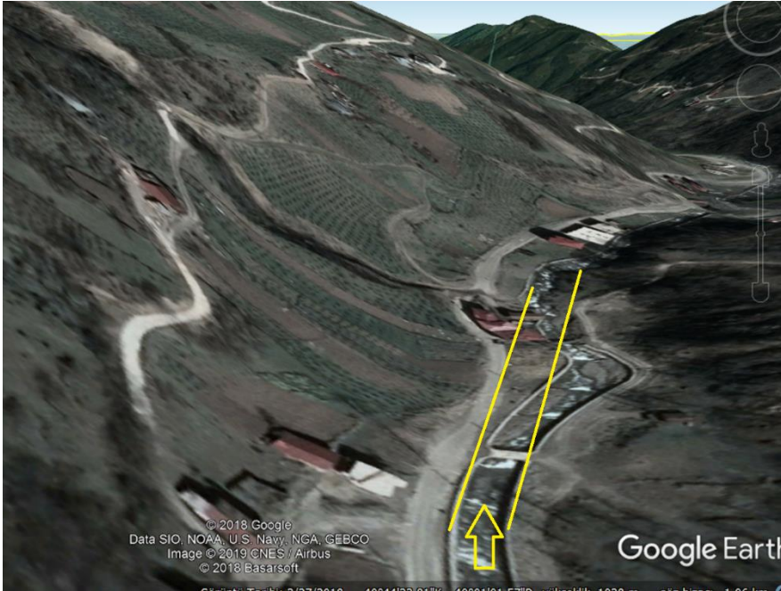
Foto 5. Nehir yatađındaki yapılařmanın engellediđi çűzűmler
