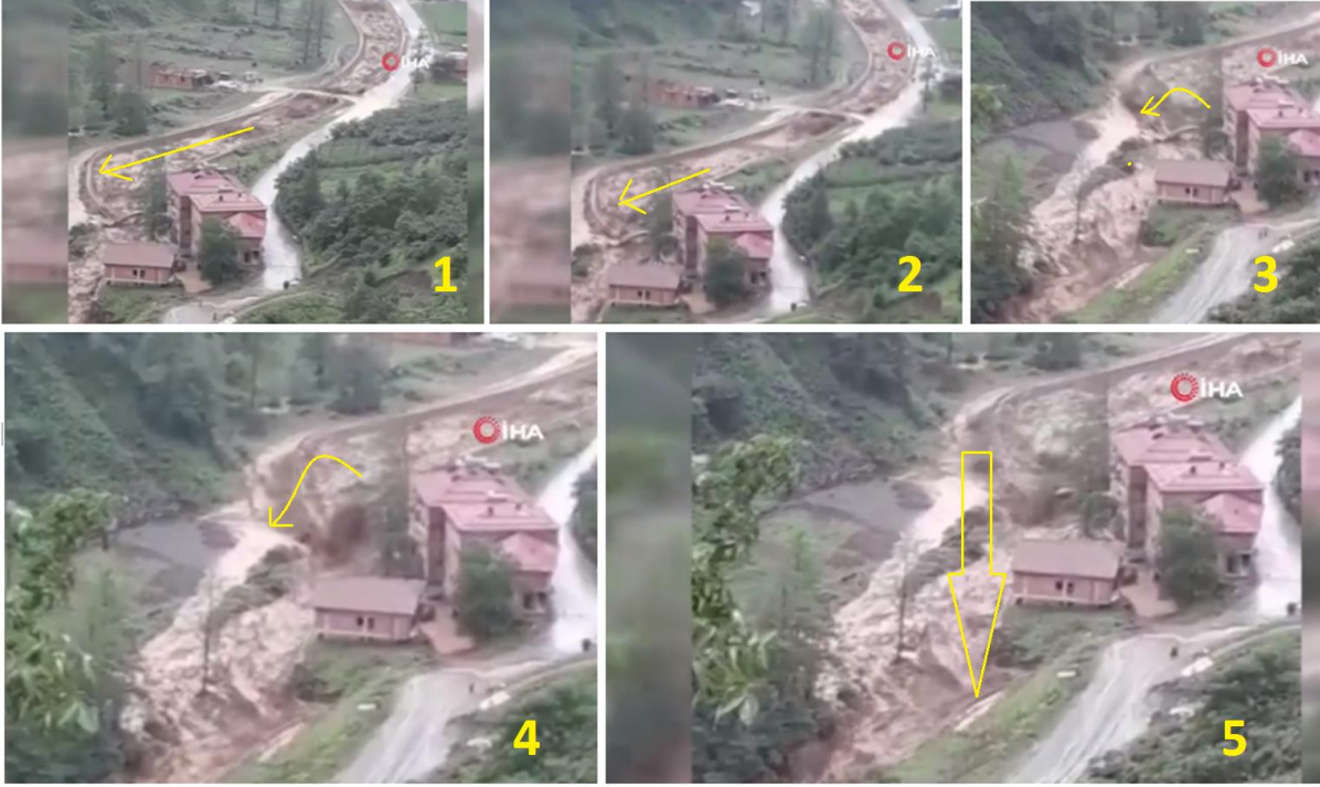
Foto 3 .Yataydaki kurb nedeniyle koruma altındaki yatağından çıkan taşkın debisi
