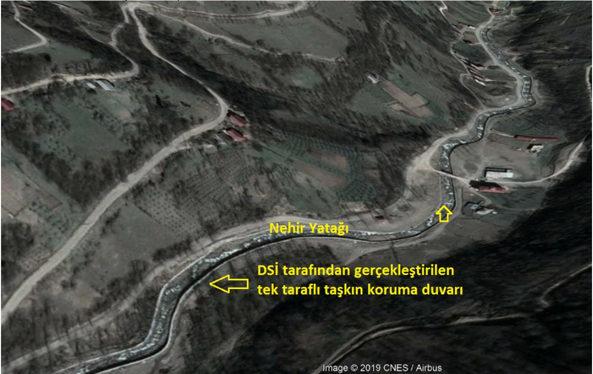
Foto 2. DSİ tarafından Taşkın Koruma Projesi kapsamında yaptırılan tek taraflı taşkın koruma duvarı
